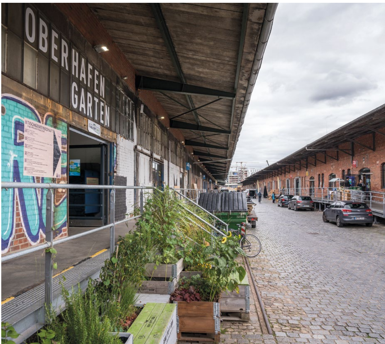
↑ Die Lagerhallen im Oberhafenquartier werden schrittweise saniert. © Miguel Ferraz
