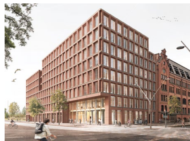
↑ Blick von der Shanghaiallee auf das Hauptzollamt und die denkmalgeschützte Fassade des Automuseums Prototyp nebenan. © DJH Architekten
